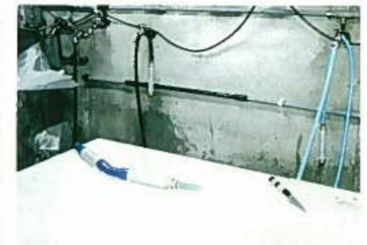
●テクノパイプ取付状況
